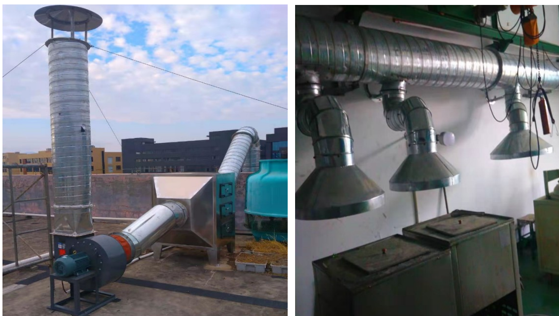
图 3-1 灌装废气收集及处理装置
