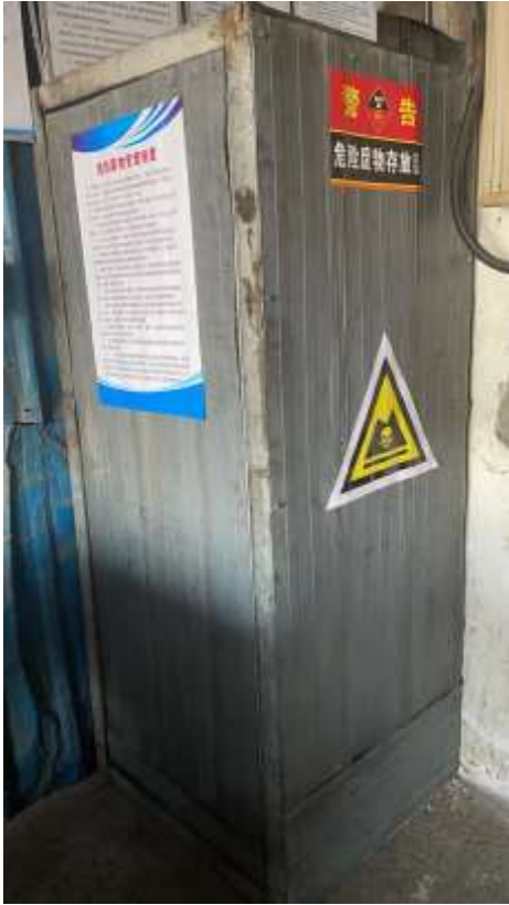
图 4.4-1 危险废物暂存间
