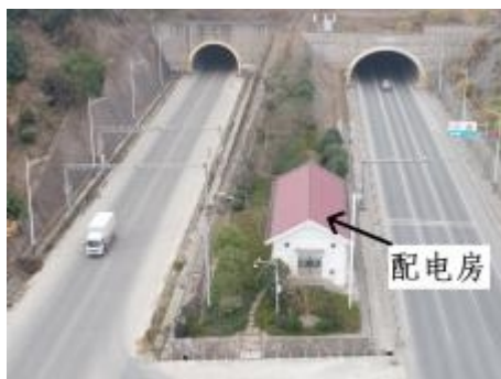
图 5.3-10 配电房周边生态恢复实拍
