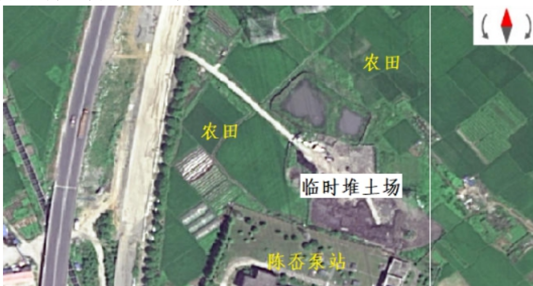
图 5.3-4 临时堆土场（陈岙泵站北侧农田内）所在地航拍图（2017 年）
