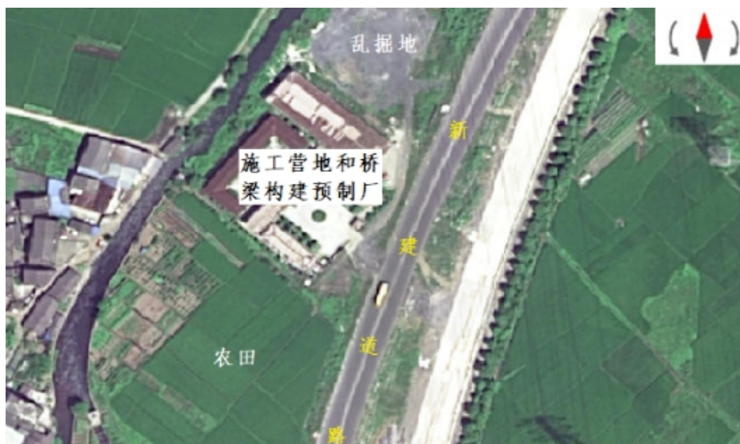
图 5.3-1 施工营地和桥梁构建预制厂所在地航拍图（2017 年）
