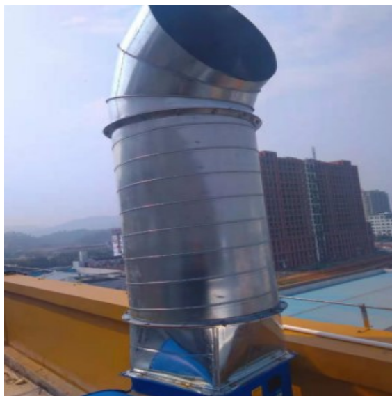
图 4.1-1 注塑废气排气筒
