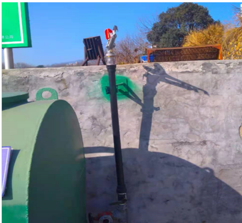
图 4-7 洒水喷淋头
