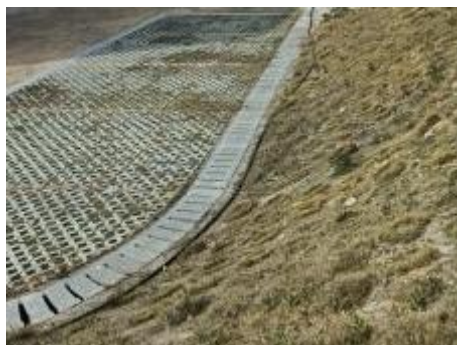
图 4.2-4 管理房附近排水沟
