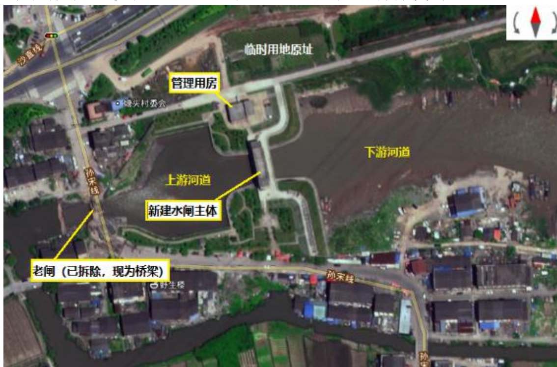
图 2.5-1 工程主体部分航拍图
