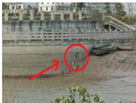
图 4.2-3 地表径流排水口
