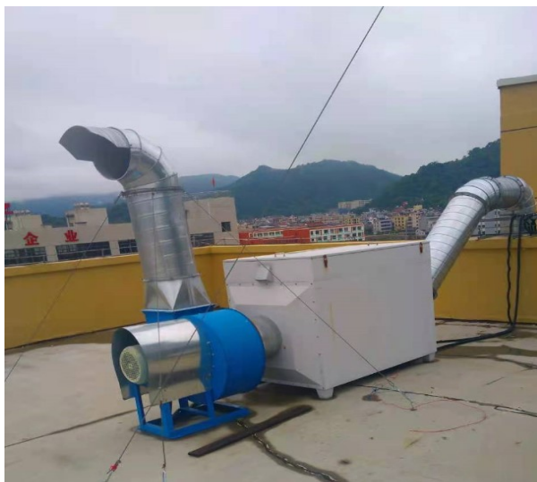
图 4.1-1 熔融挤出废气处理装置
