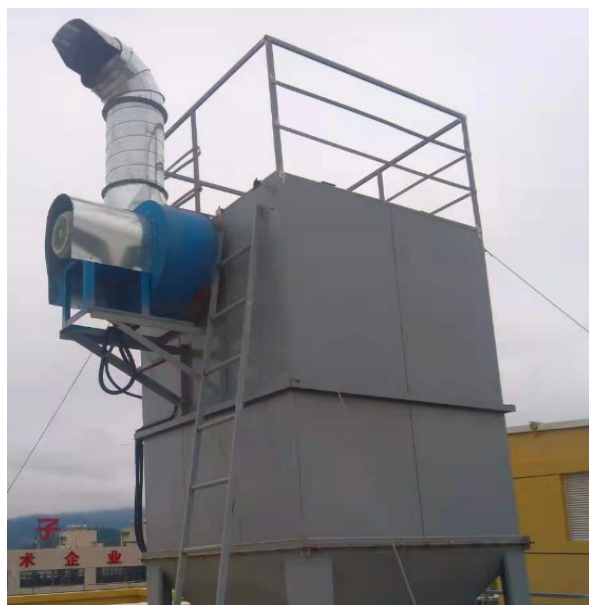
图 4.1-2 脉冲式布袋式除尘器
