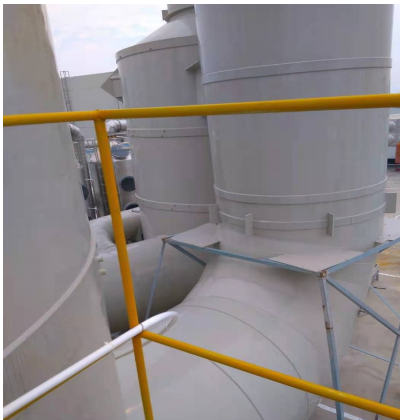
图 4.1-2 酸雾废气处理设施
