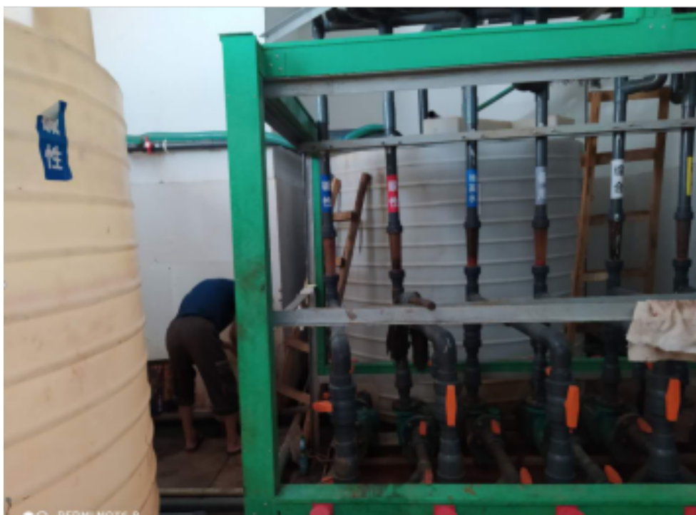
图 4.1-4 生产废水分质分流
