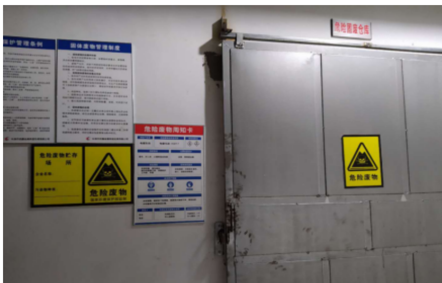
图 4.1-5 危险废物暂存间
