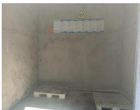
图 4.4-1 危废暂存设施
