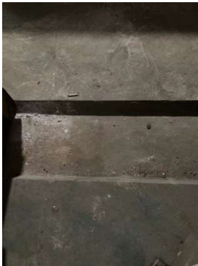
图 4.2-1 防腐防渗地坪、导流渠
