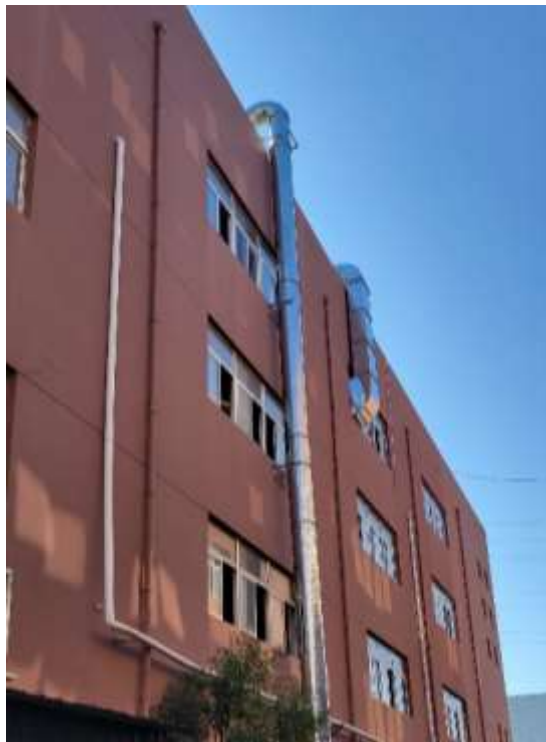
图 4.2-1 冷锻油雾排气筒
