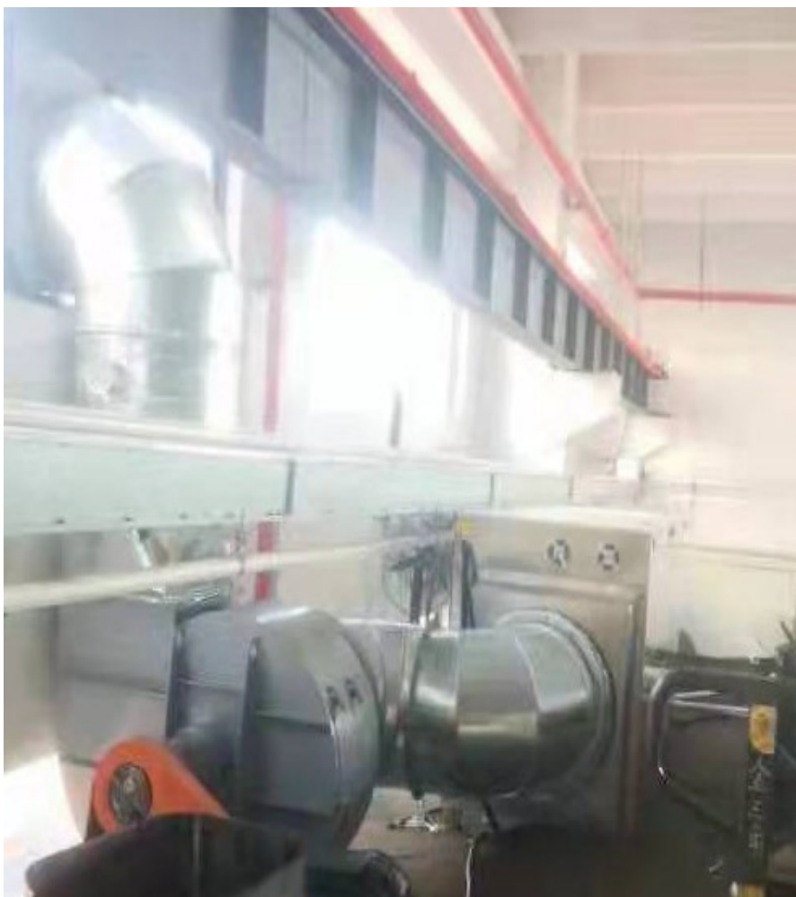
图 4.1-1UV 光氧催化+活性炭净化装置
