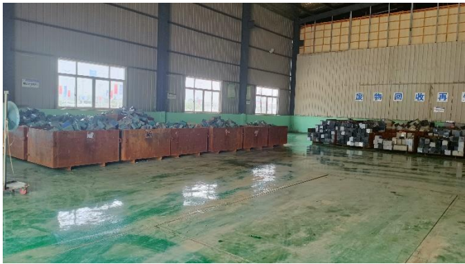
防腐防渗地坪
