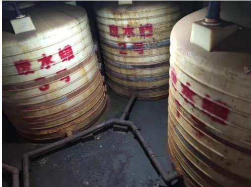
地下废水储罐
