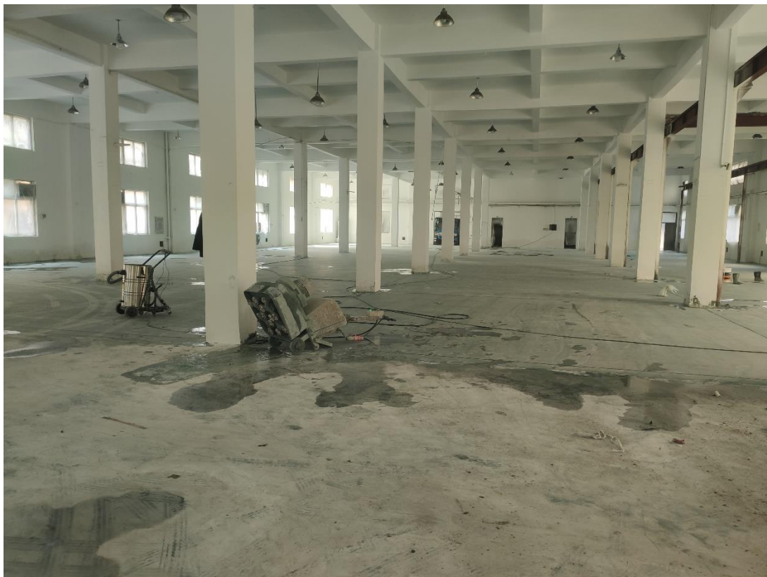
图 2-10 车间现场照片
