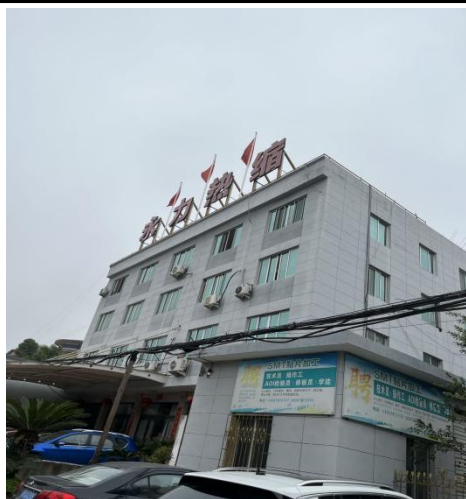
西侧：永力热缩有限公司
