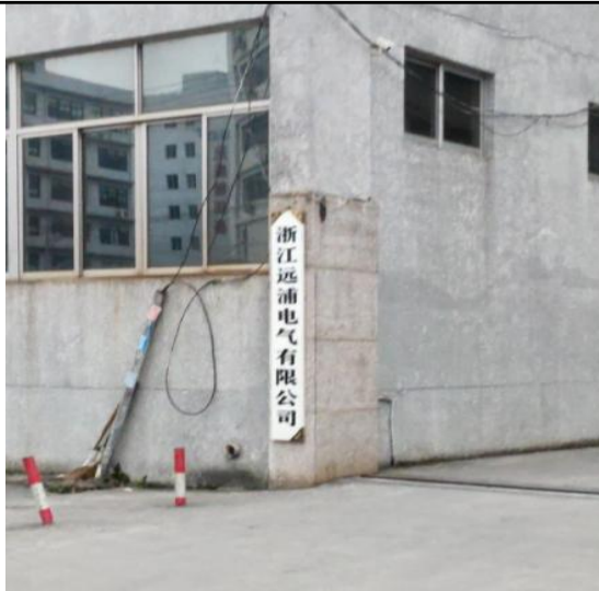
东南侧：浙江远浦电气有限公司的厂房
