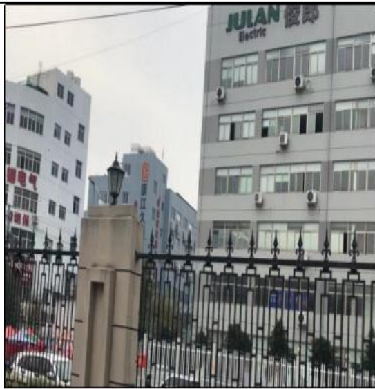
西南侧：浙江俊朗电气有限公司
