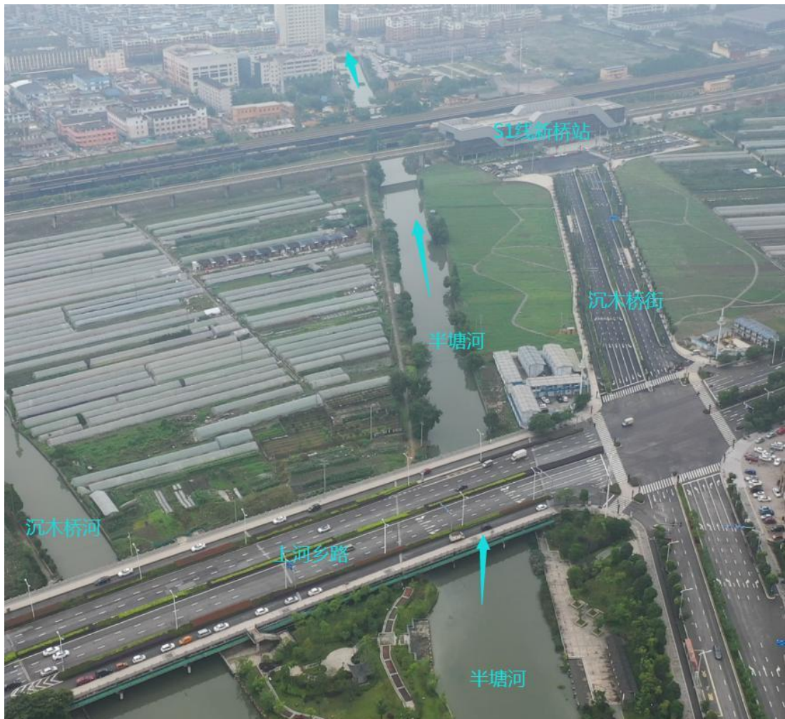
图 3-4 BTN0+000~BTN0+700 段现场照片
