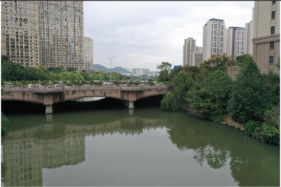
图 3-11 半塘河古岸路桥梁现状图二
