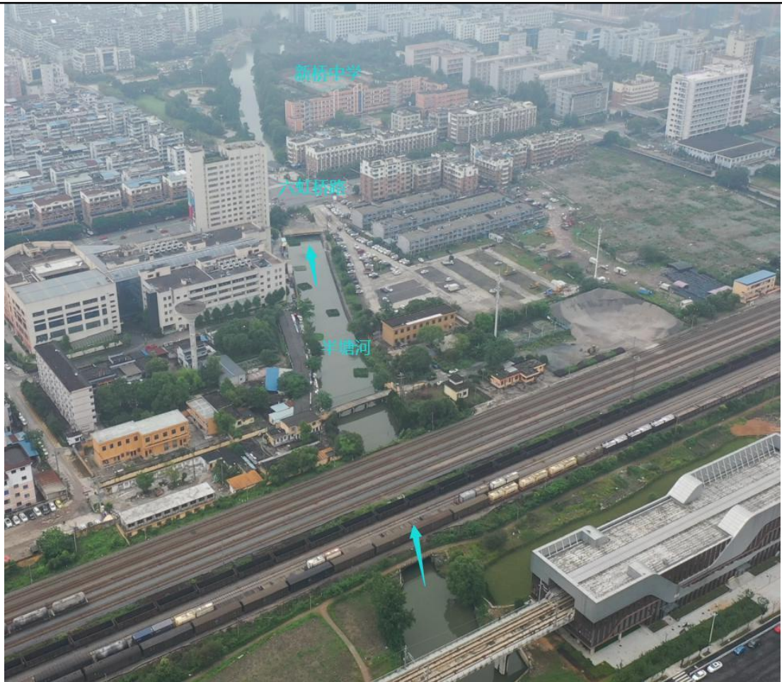
图 3-5 BTN0+700~BTN1+100 段现场照片
