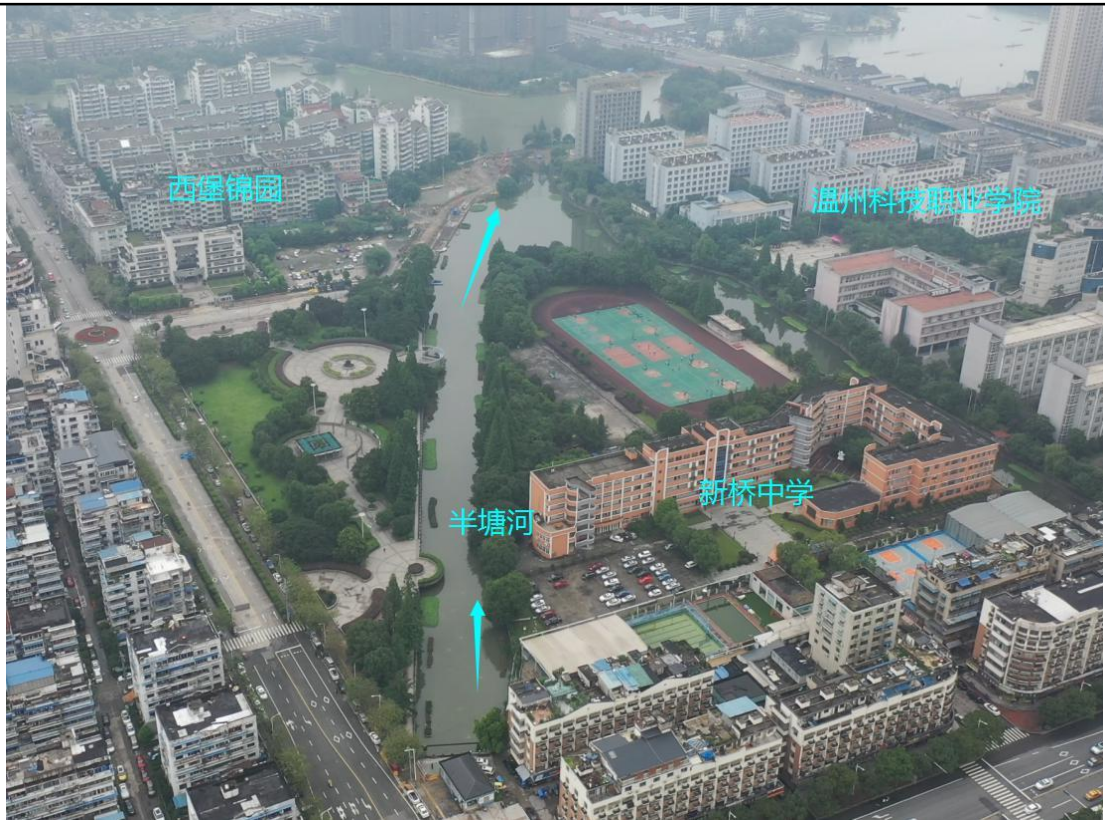
图 3-6 BTN1+100~BTN1+626 段现场照片
