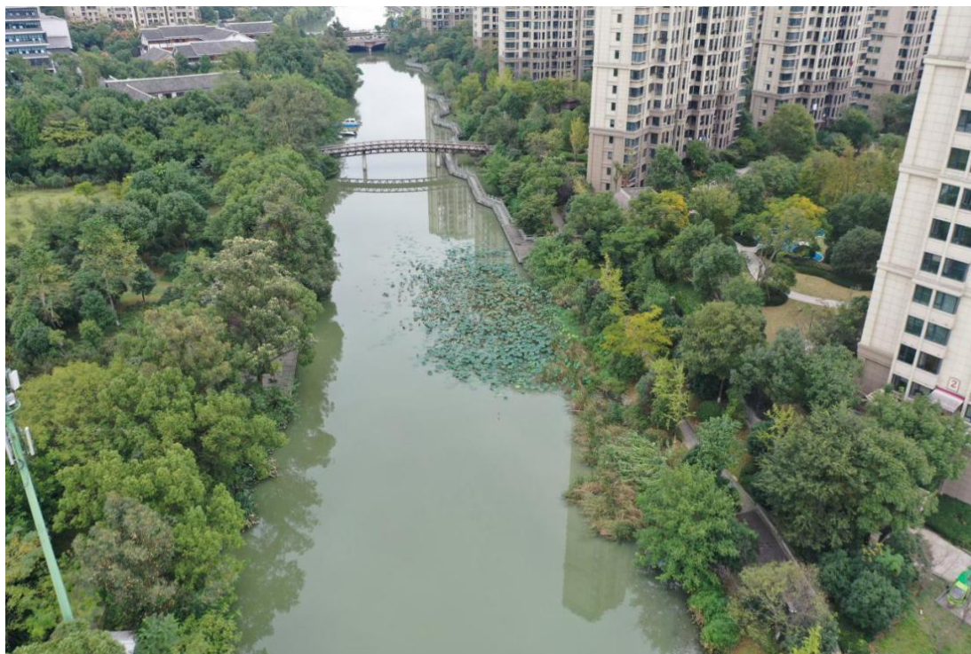
图 3-10 半塘河无名桥 1 桥梁现状图一
