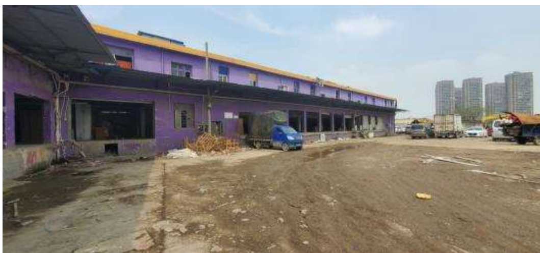
图 3.3-6 第② 3 区块、第② 4 区块地面硬化和建构筑物近状（2021 年 05 月）
