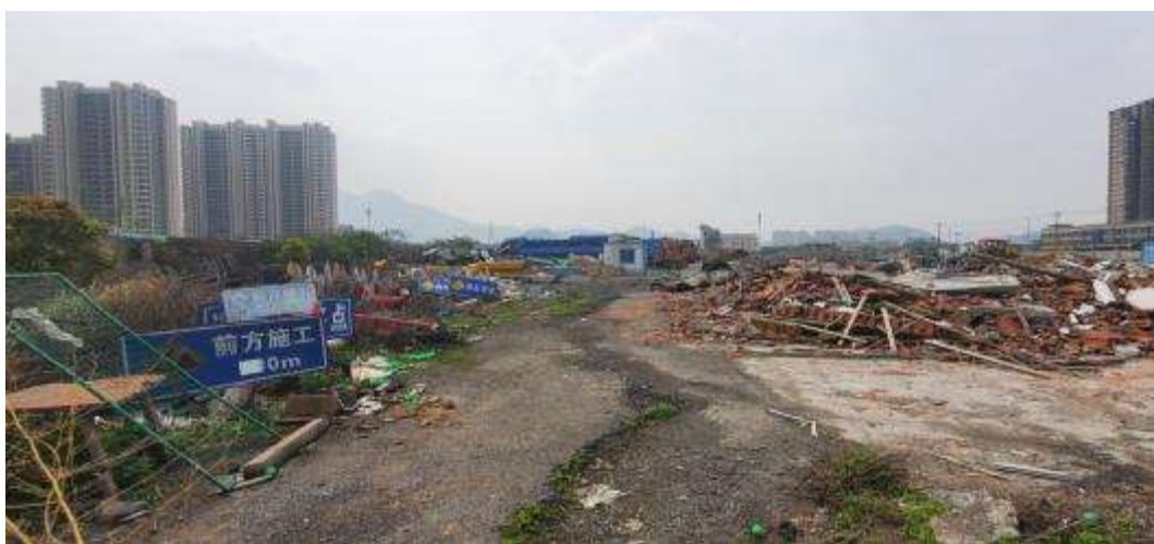
图 3.3-4 第①区块地面硬化和建筑垃圾堆放近状（2021 年 05 月）
