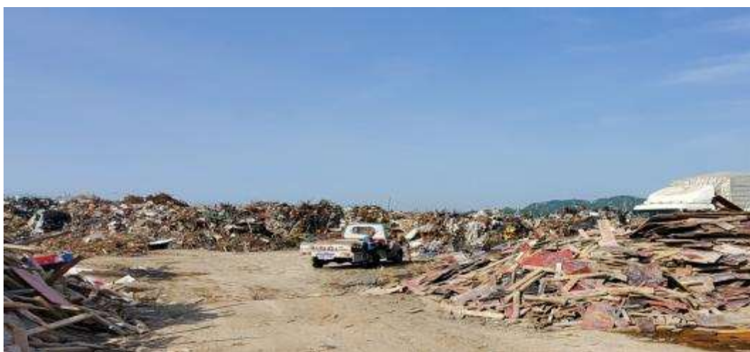
图 3.3-8 第③ 2 区块地面硬化和建筑垃圾堆放近状（2021 年 05 月）
