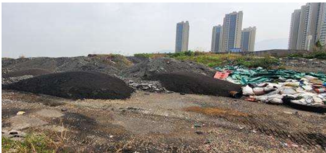
图 3.3-3 第①区块物料堆场和建筑垃圾堆放近状（2021 年 05 月）
