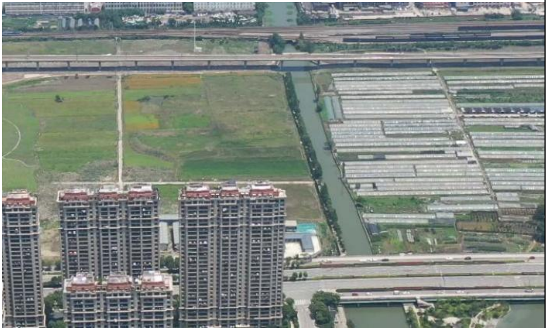
图 3-4 CMN0+000~CMN0+600 段现场照片
