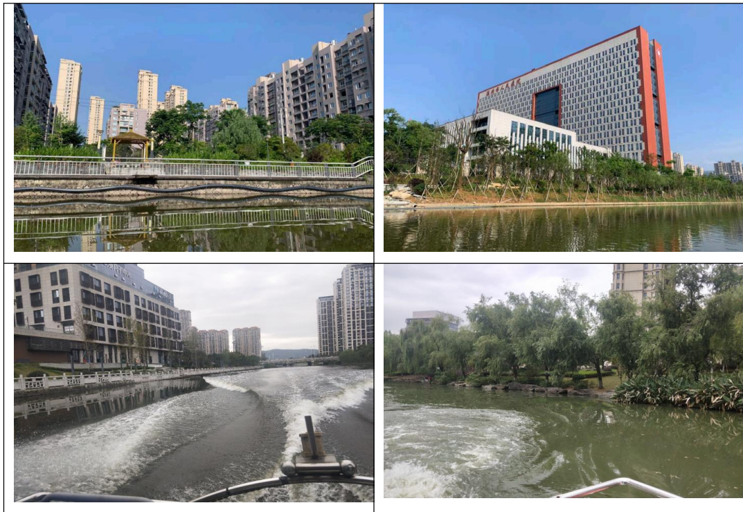
图 3-6 沉木桥河挡墙图片
