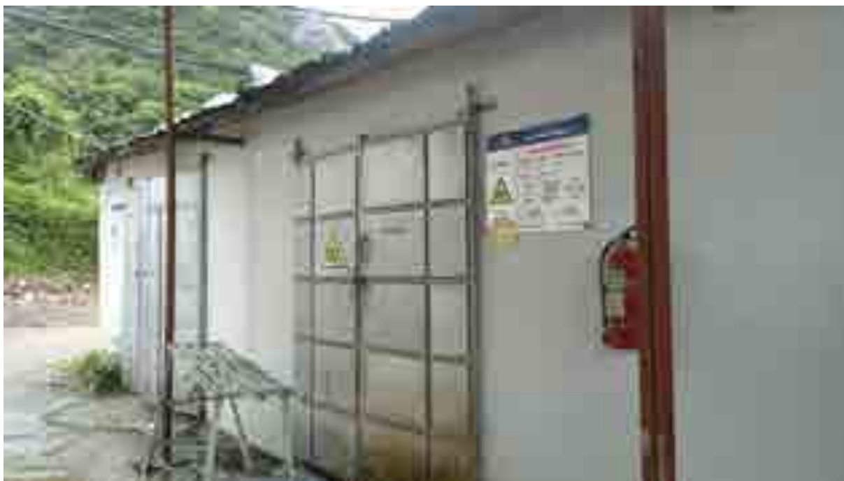
图 2.2-7 本单位危险废物暂存仓库
