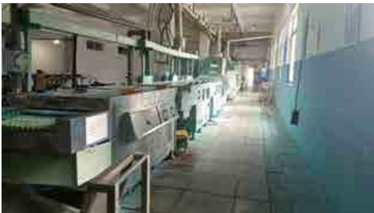
图 2.2-4 本单位蚀刻生产线
