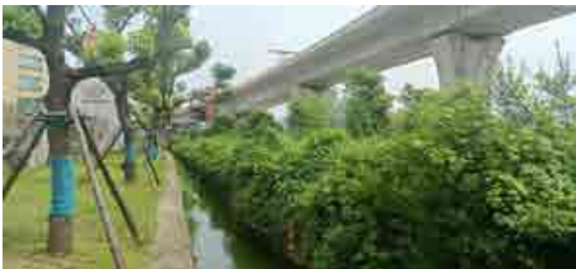
图 2.2-11 企业东侧现状（引水渠及正在建设的市域铁路 S2 线）
