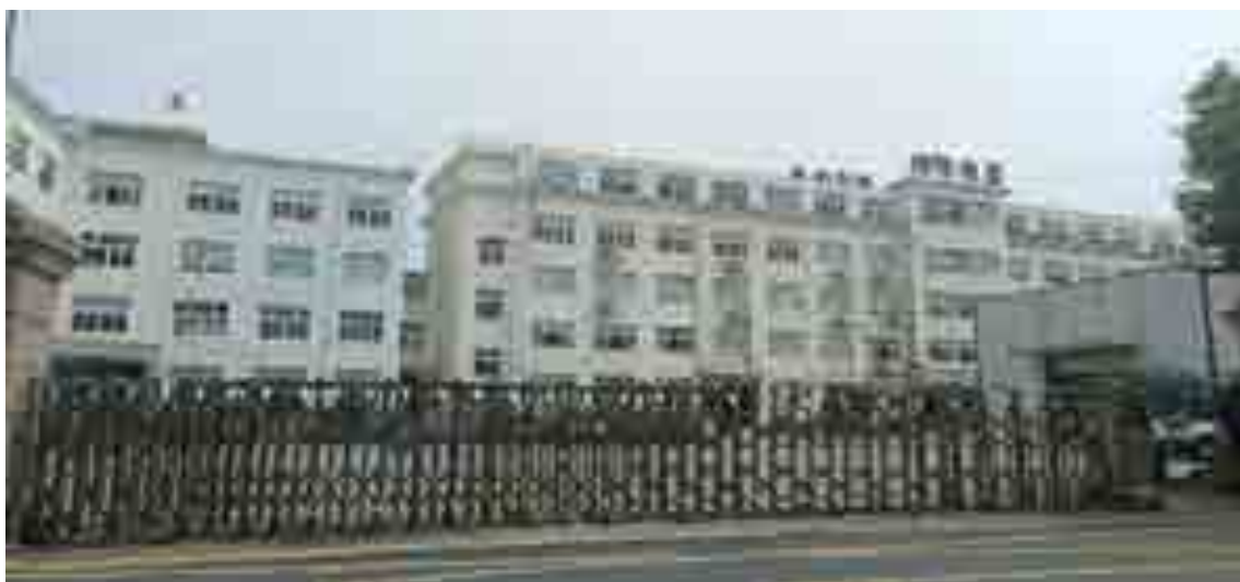
图 2.2-8 企业西侧现状（浙江裕华电器有限公司）
