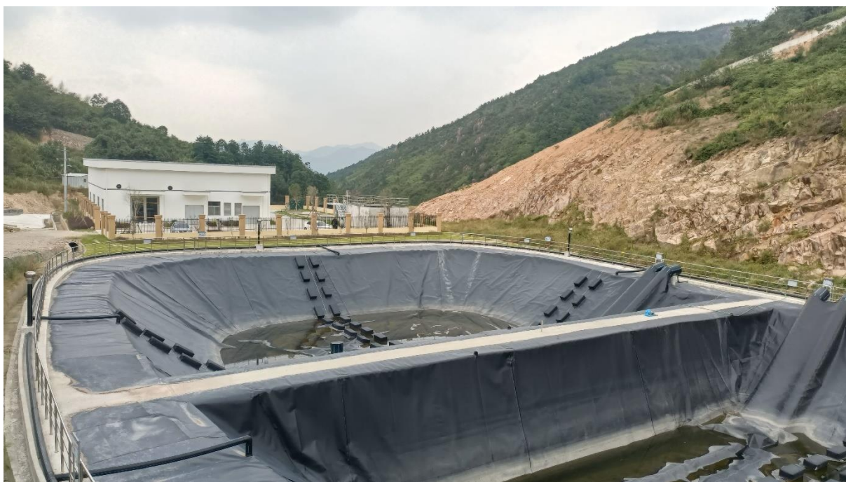
图 2.2-4 渗滤液调节池
