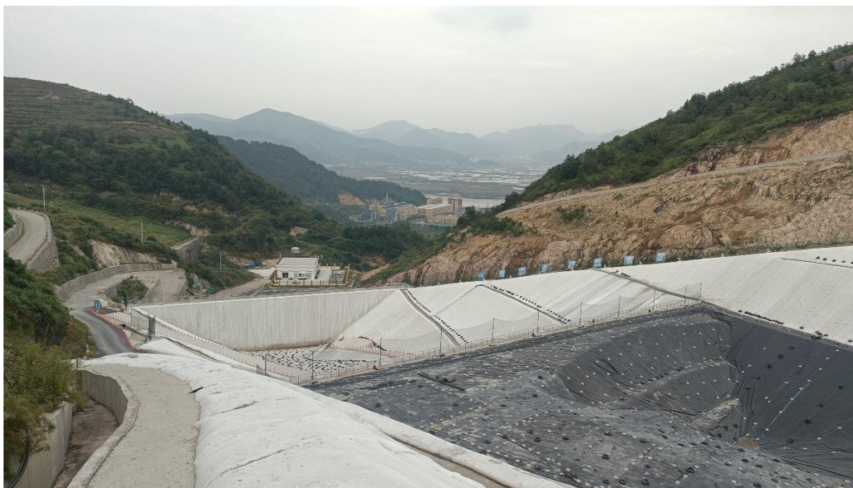
图 2.2-3 一般工业固废填埋库区
