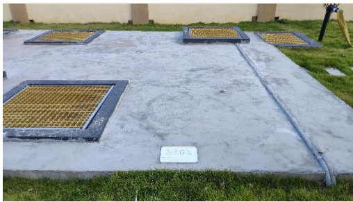
综合车间外地下污泥储池
