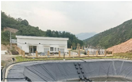
渗滤液处理站
