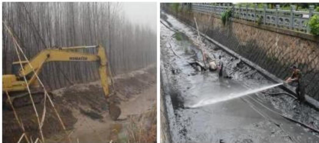
图 2-7 干水清淤现场照片示意图
