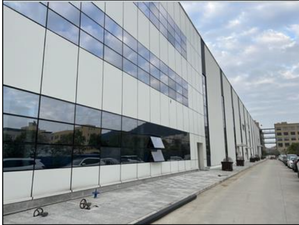
厂区已建 1#厂房
