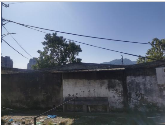
本项目（租赁厂房）西侧：龙翔路
