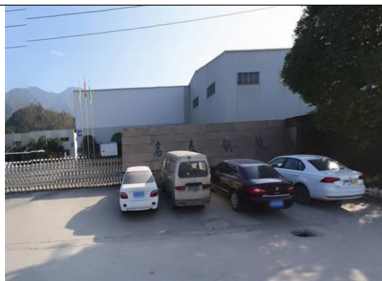
西厂区南侧：镇中东路及浙江名泰五金科技园
