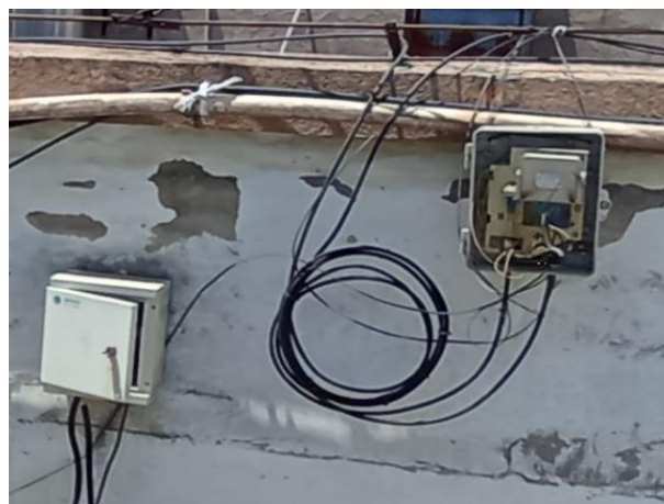
图 4.3-19 废气处理设施工况监控
