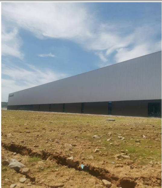
东侧：金海路，过路为远景（苍南）新能源有限公司一期工程 A2 地块主机厂车间
