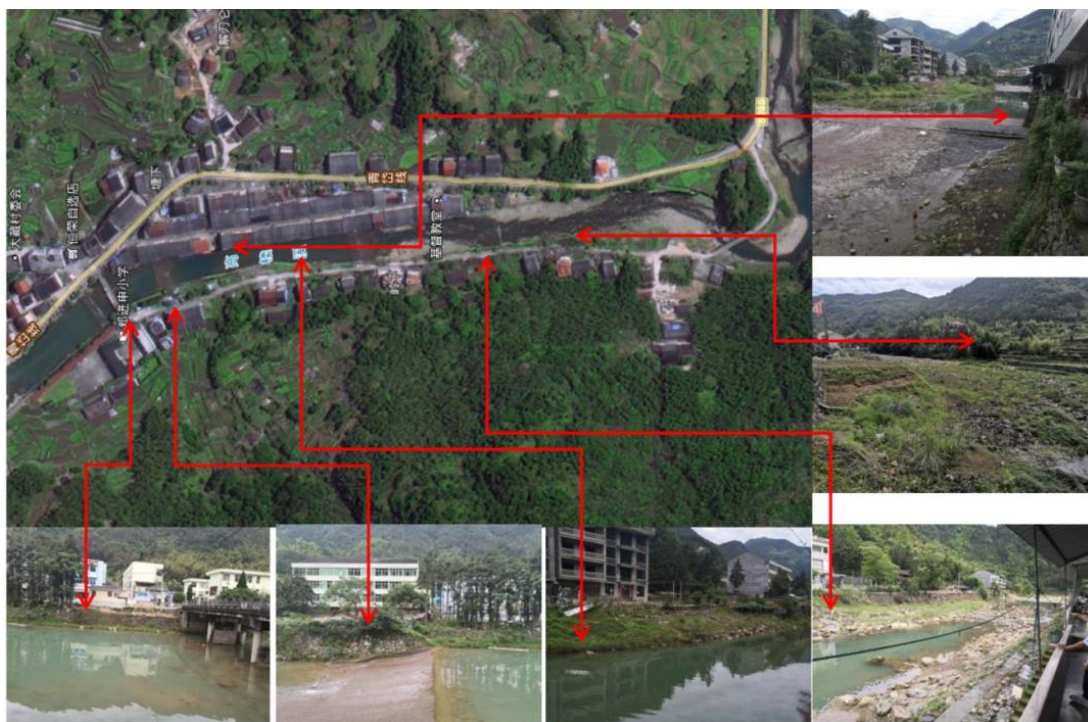
图 3-3 高楼溪枫桥段防洪堤河段现状概貌
