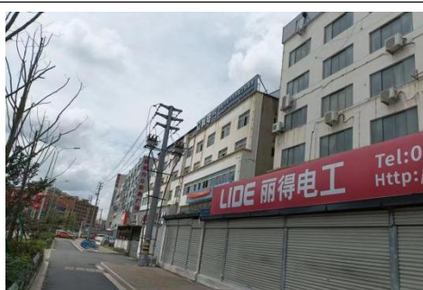
西南侧：立枫电气有限公司
