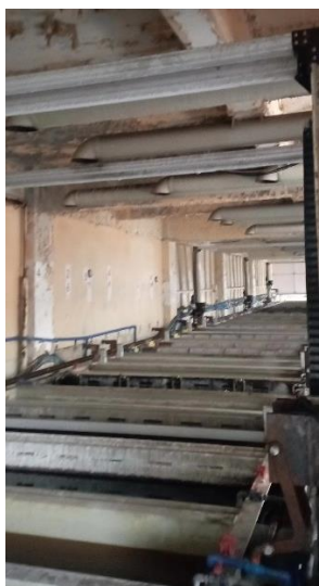
图 4.3-3 铝氧化生产线顶部集气口
