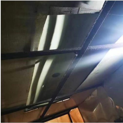
图 4.3-1 镀锌生产线顶部集气口
