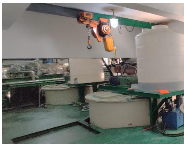
图 4.2-5 地面防腐、防渗工程
