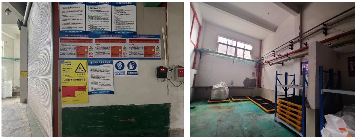
图 4.4-1、图 4.4-2 原厂址危险废物暂存间内外景
