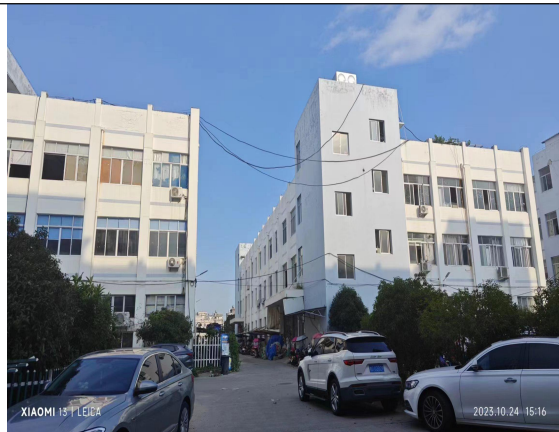
西侧：乐清市博剑电器有限公司和道路 为温州东兴电子有限公司
