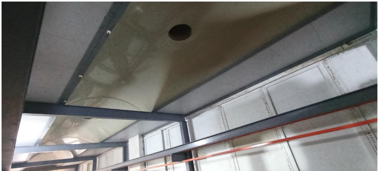
图 4.3-2 生产线 1 上方集气设施
