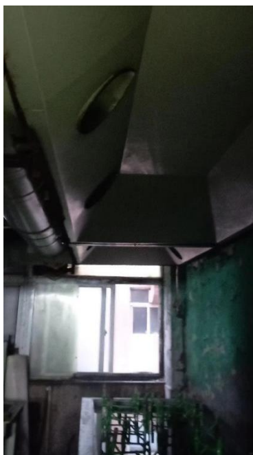
图 4.3-10 挂具退镀废气集气口
