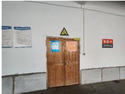
图 4.5-2 危废暂存中心 2
