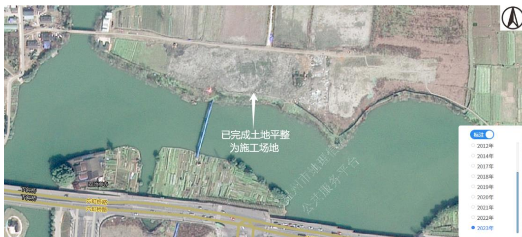
图 2.5-4 下斜村消纳点（施工已结束，2023 年航拍影像）
