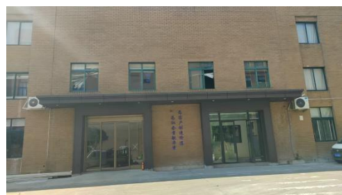
南侧：华昊无纺布有限公司
