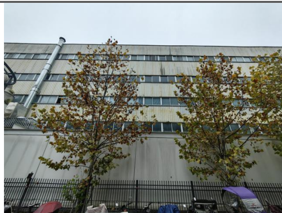
北侧：朗诗德电气有限公司
