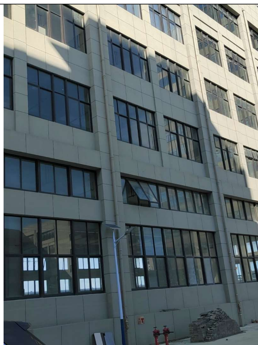
北侧：温州发扬科技有限公司厂房
