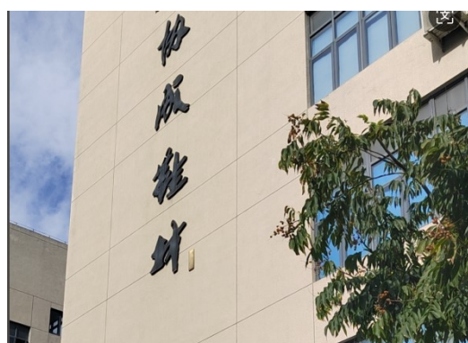
西北侧：园区 8 栋
